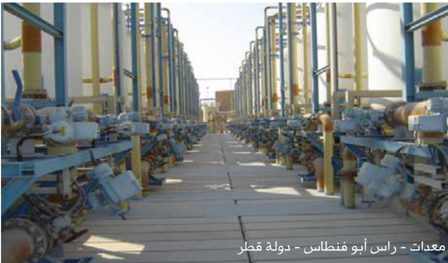
وحدات معالجة ( فلاتر الحجر الجيري )- راس أبو فنطاس - دولة قطر
