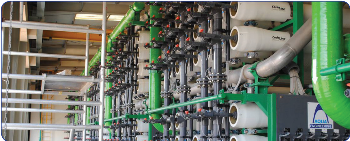
محطة الزوراء المركزية بالهيئة الاتحادية للكهرباء والماء في إمارة عجمان
