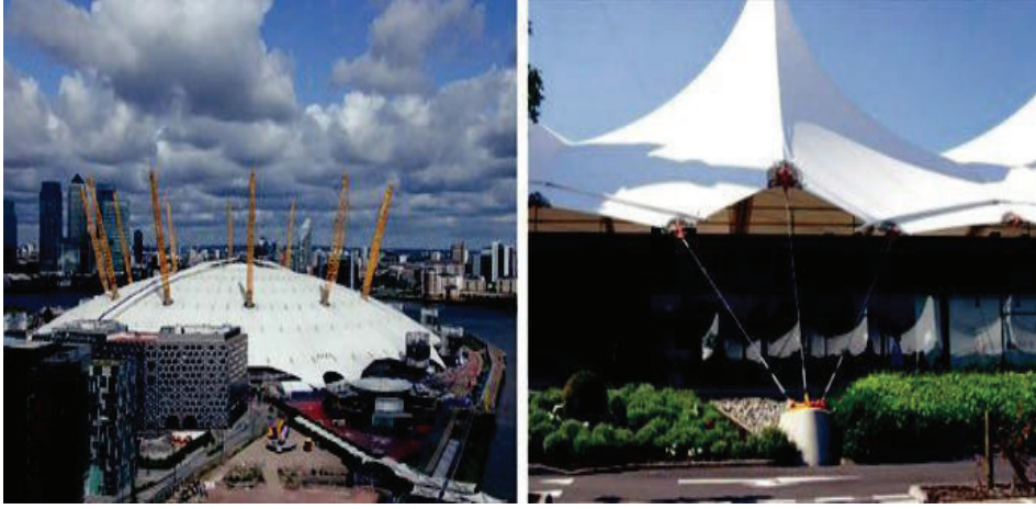
شكل 2.5: هيكل غشائي مشدود عند الحواف (قبة الألفية في لندن).
